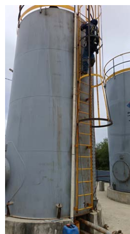
Installation du capteur de niveau de carburant DUT-E S7
