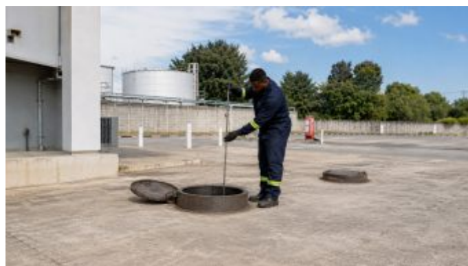
Medición del nivel de combustible con varilla de medición
