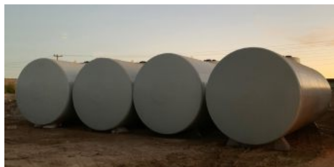
Depósitos de combustible antes de la instalación
