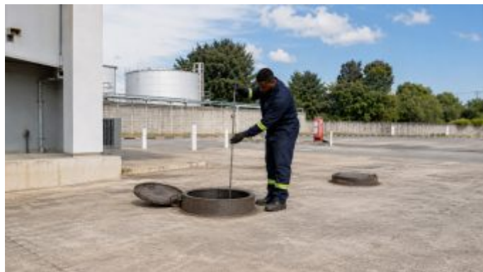
Mesure du niveau de carburant avec une jauge manuelle
