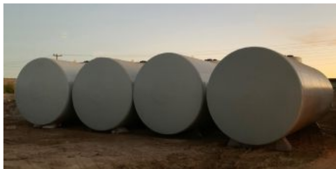
Réservoirs de carburant avant l'installation
